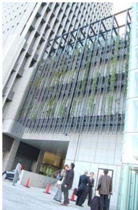
植栽樹(コンテナ)を2段に使ったJAビル・経団連ビル北面の壁面緑化
