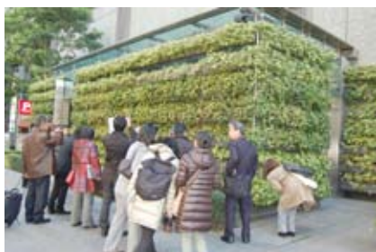
新丸ビルの駐輪場壁面緑化。ヘデラなど3種類を使い単調になりやすい緑化を工夫している。
